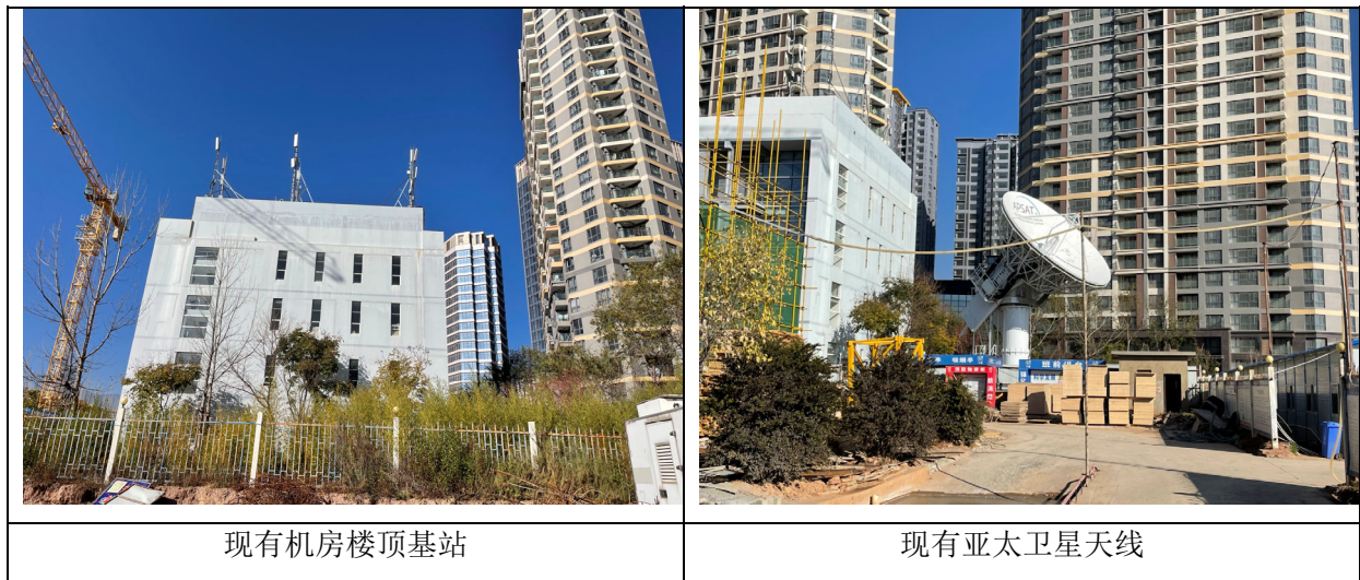
图 3.1-5 院内现有天线情况
